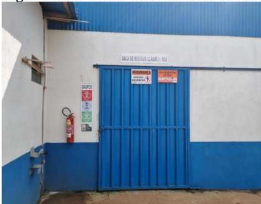
Figura 8: Sala de armazenamento de RSS
