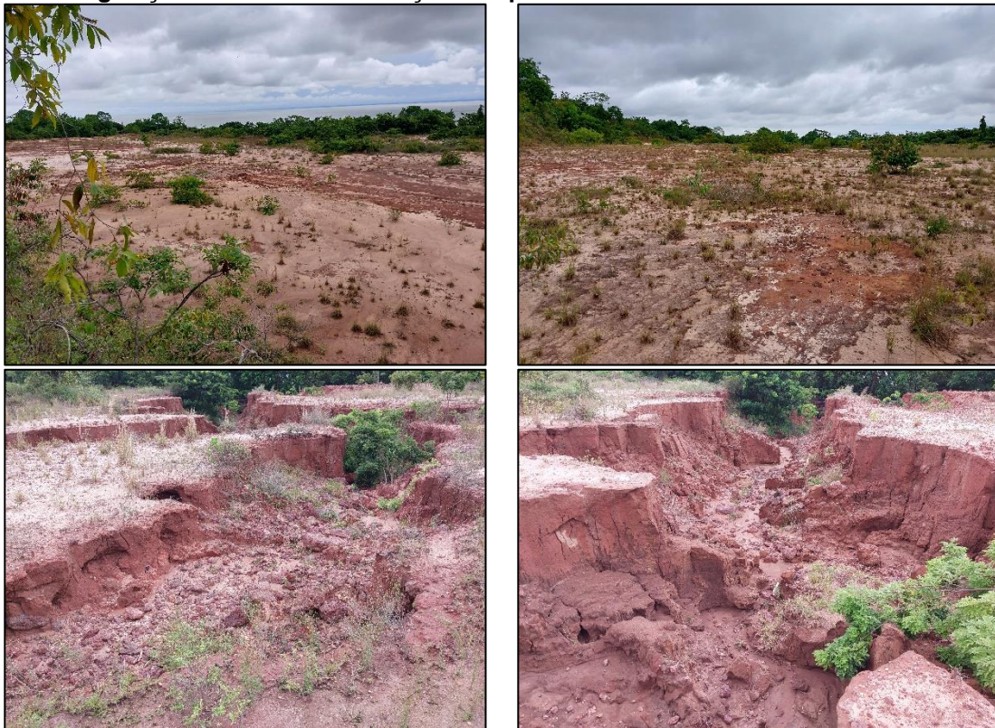
Figura 22 - Evidências de degradação, alteração da cobertura do solo, supressão de vegetação nativa e intensificação dos processos erosivos na área desafetada.
