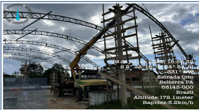
FOTO 04: 01 ITEM 6.1.1 - ARCO TRELIÇADO - BANCOS: PERFIL U 127x50x3,04 MONTANTES E DIAGONAIS PERFIL 2xL 30x30x3, PINTADOS COM FUNDO ANTICORROSIVO E TINTA ESMALTE SINTÉTICO FOSCO (DUAS DEMÃOS), INCLUSO IÇAMENTO COM GUINDASTE HIDRÁULICO
