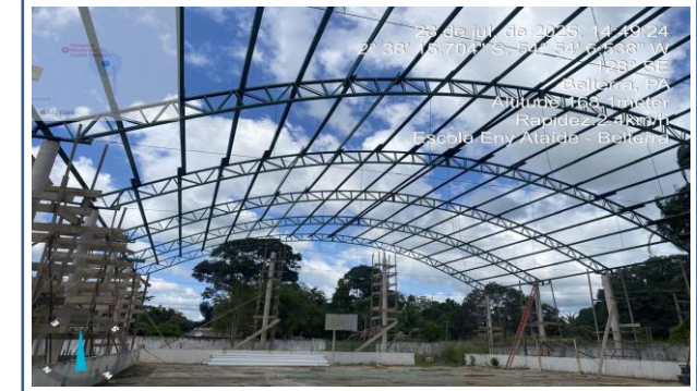
FOTO 06: 01 ITEM 6.1.1 - ARCO TRELIÇADO - BANCOS: PERFIL U 127x50x3,04 MONTANTES E DIAGONAIS PERFIL 2xL 30x30x3, PINTADOS COM FUNDO ANTICORROSIVO E TINTA ESMALTE SINTÉTICO FOSCO (DUAS DEMÃOS), INCLUSO IÇAMENTO COM GUINDASTE HIDRÁULICO
