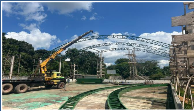
FOTO 01 ITEM 6.1.1 - ARCO TRELIÇADO - BANCOS: PERFIL U 127x50x3,04 MONTANTES E DIAGONAIS PERFIL 2xL 30x30x3, PINTADOS COM FUNDO ANTICORROSIVO E TINTA ESMALTE SINTÉTICO FOSCO (DUAS DEMÃOS), INCLUSO IÇAMENTO COM GUINDASTE HIDRÁULICO
