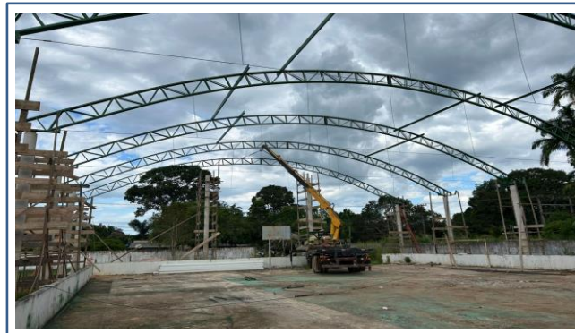
FOTO 02: ITEM 6.1.1 - ARCO TRELIÇADO - BANCOS: PERFIL U 127x50x3,04 MONTANTES E DIAGONAIS PERFIL 2xL 30x30x3, PINTADOS COM FUNDO ANTICORROSIVO E TINTA ESMALTE SINTÉTICO FOSCO (DUAS DEMÃOS), INCLUSO IÇAMENTO COM GUINDASTE HIDRÁULICO
