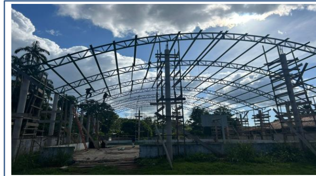
FOTO 05: 01 ITEM 6.1.1 - ARCO TRELIÇADO - BANCOS: PERFIL U 127x50x3,04 MONTANTES E DIAGONAIS PERFIL 2xL 30x30x3, PINTADOS COM FUNDO ANTICORROSIVO E TINTA ESMALTE SINTÉTICO FOSCO (DUAS DEMÃOS), INCLUSO IÇAMENTO COM GUINDASTE HIDRÁULICO
