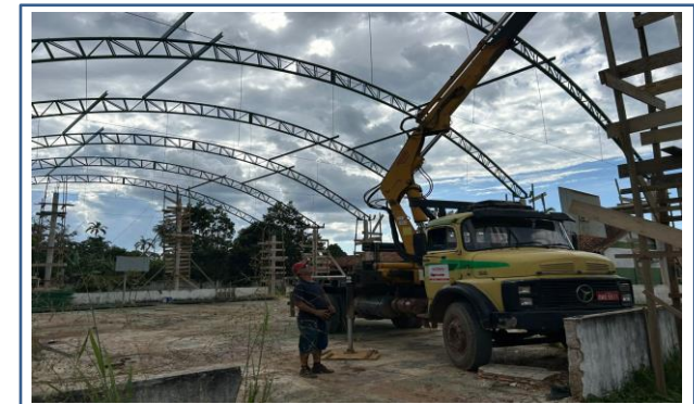
FOTO 03: ITEM 6.1.1 - ARCO TRELIÇADO - BANCOS: PERFIL U 127x50x3,04 MONTANTES E DIAGONAIS PERFIL 2xL 30x30x3, PINTADOS COM FUNDO ANTICORROSIVO E TINTA ESMALTE SINTÉTICO FOSCO (DUAS DEMÃOS), INCLUSO IÇAMENTO COM GUINDASTE HIDRÁULICO
