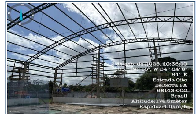
**FOTO 03: 6.3.1 - FABRICAÇÃO E INSTALAÇÃO DE CONTRAVENTAMENTO COM BARRA DE AÇO CA 25 DIÂMETRO DE 10MM COM COMPRIMENTO DE 5,85M E ESTICADORES TIPO OLHAL-OLHA NAS EXTREMIDADES**
