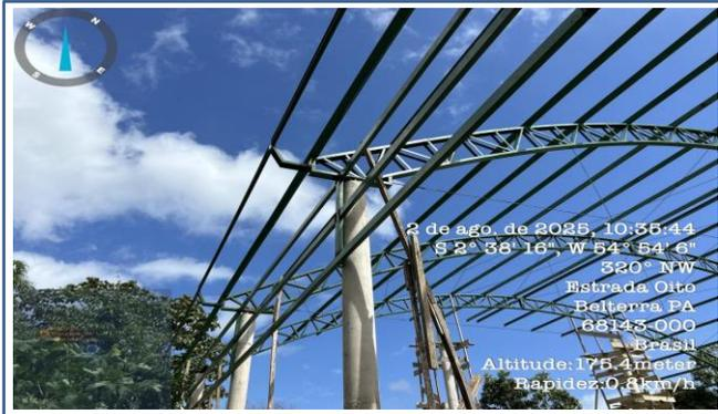
**FOTO 01 ITEM 6.3.1 - FABRICAÇÃO E INSTALAÇÃO DE CONTRAVENTAMENTO COM BARRA DE AÇO CA 25 DIÂMETRO DE 10MM COM COMPRIMENTO DE 5,85M E ESTICADORES TIPO OLHAL-OLHA NAS EXTREMIDADES**
