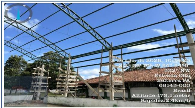
**FOTO 04: 01 ITEM 7.1 - FORNECIMENTO E INSTALAÇÃO DE PERFIL C125X50X17X2.66, INCLUINDO PINTURA ANTIFERRUGINOSA E PINTURA COM TINTA ESMALTE SINTÉTICO FOSCO (2 DEMÃOS)**
