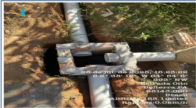
FOTO 10: ITEM 8.6 - CAIXA ENTERRADA PARA DRENAGEM PLUVIAL RETANGULAR EM ALVENARIA COM TIJOLOS CERÂMICOS, DIMENSÕES INTERNAS: 0,5X0,5X0,5 M PARA REDE DE DRENAGEM. AF\_05/2018
