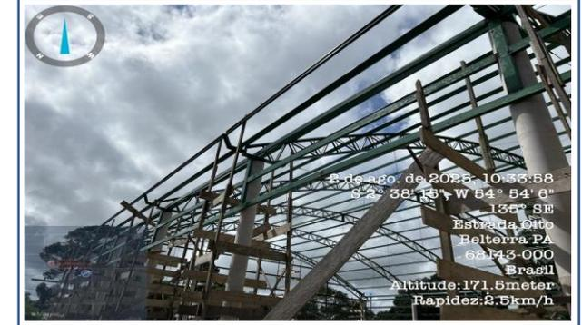
**FOTO 06: 01 ITEM 7.1 FORNECIMENTO E INSTALAÇÃO DE PERFIL C125X50X17X2.66, INCLUINDO PINTURA ANTIFERRUGINOSA E PINTURA COM TINTA ESMALTE SINTÉTICO FOSCO (2 DEMÃOS)**
