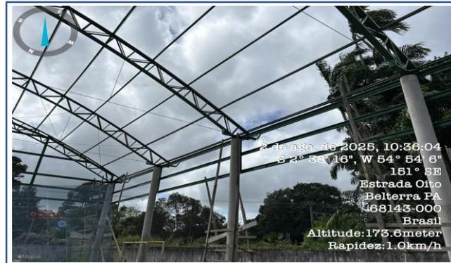
**FOTO 02: ITEM 6.3.1 - FABRICAÇÃO E INSTALAÇÃO DE CONTRAVENTAMENTO COM BARRA DE AÇO CA 25 DIÂMETRO DE 10MM COM COMPRIMENTO DE 5,85M E ESTICADORES TIPO OLHAL-OLHA NAS EXTREMIDADES**
