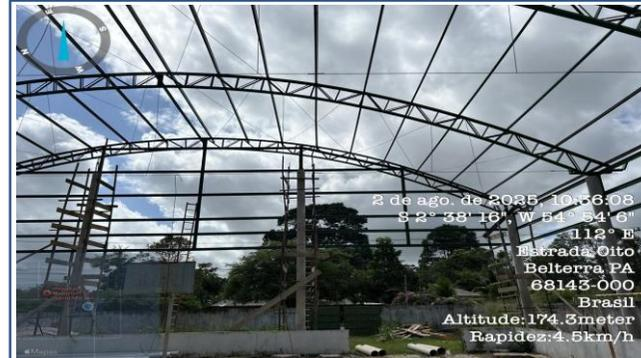
**FOTO 05: 01 ITEM 7.1 - FORNECIMENTO E INSTALAÇÃO DE PERFIL C125X50X17X2.66, INCLUINDO PINTURA ANTIFERRUGINOSA E PINTURA COM TINTA ESMALTE SINTÉTICO FOSCO (2 DEMÃOS)**
