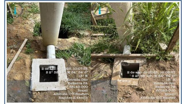
FOTO 12: 8.6 - CAIXA ENTERRADA PARA DRENAGEM PLUVIAL RETANGULAR EM ALVENARIA COM TIJOLOS CERÂMICOS, DIMENSÕES INTERNAS: 0,5X0,5X0,5 M PARA REDE DE DRENAGEM. AF\_05/2018
