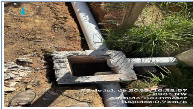
FOTO 11: ITEM 8.6 - CAIXA ENTERRADA PARA DRENAGEM PLUVIAL RETANGULAR EM ALVENARIA COM TIJOLOS CERÂMICOS, DIMENSÕES INTERNAS: 0,5X0,5X0,5 M PARA REDE DE DRENAGEM. AF\_05/2018
