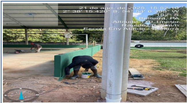
FOTO 10: ITEM 8.2 - TUBO PVC, SÉRIE R, ÁGUA PLUVIAL, DN 150 MM, FORNECIDO E INSTALADO EM CONDUTORES VERTICAIS DE ÁGUAS PLUVIAIS. AF_06/2022
