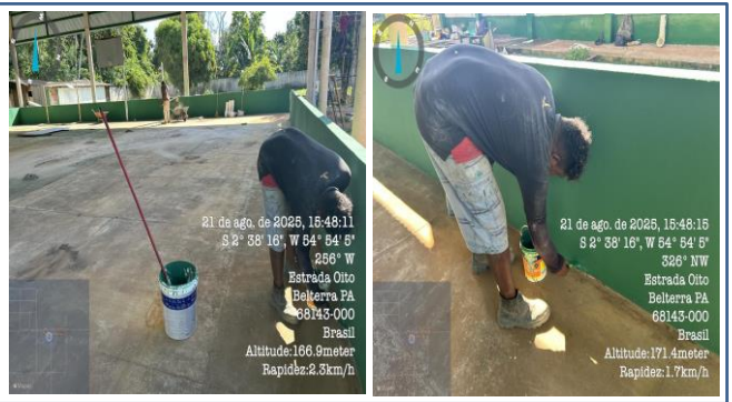
FOTO 15: ITEM 9.1 - Latex acrílica sobre muro
