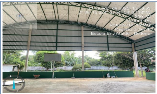
FOTO 03: ITEM 6.4.1 - Cobertura - telha em aço galvanizado e=0,5mm
