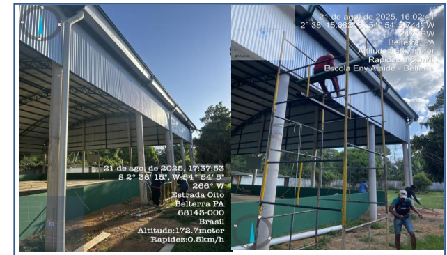
FOTO 12: 8.2 - TUBO PVC, SÉRIE R, ÁGUA PLUVIAL, DN 150 MM, FORNECIDO E INSTALADO EM CONDUTORES VERTICAIS DE ÁGUAS PLUVIAIS. AF_06/2022
