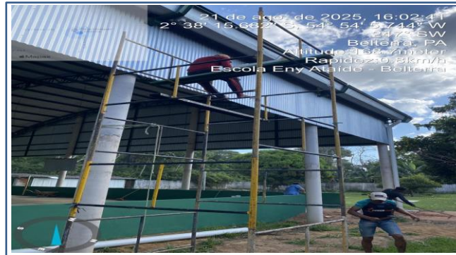
FOTO 08: ITEM 8.1 - Calha em chapa galvanizada
