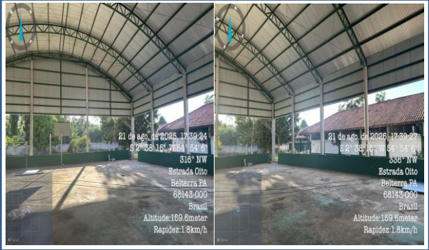
FOTO 17: ITEM 10.1 - Limpeza geral e entrega da obra
