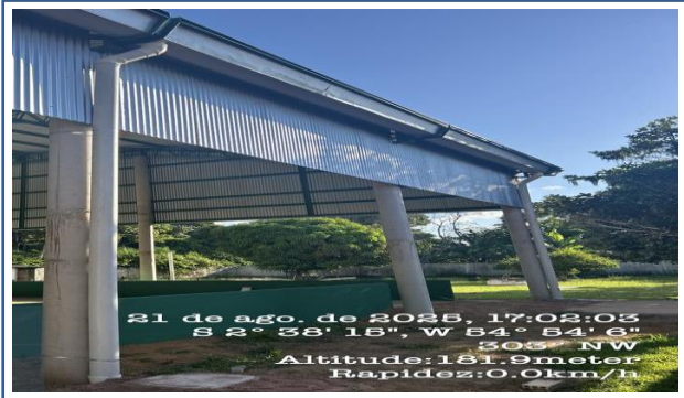
FOTO 15: ITEM 8.8: JOELHO 45 GRAUS, PVC, SERIE R, ÁGUA PLUVIAL, DN 150 MM, JUNTA ELÁSTICA, FORNECIDO E INSTALADO EM CONDUTORES VERTICAIS DE ÁGUAS PLUVIAIS. AF_06/2022
