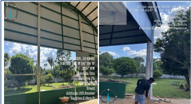
FOTO 04: ITEM 7.2 - Cobertura - telha em aço galvanizado e=0,5mm
