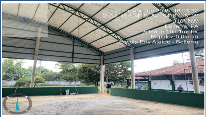
FOTO 01 ITEM 6.4.1 - Cobertura - telha em aço galvanizado e=0,5mm
