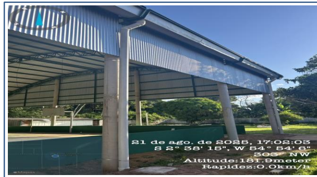
FOTO 11: ITEM 8.2 - TUBO PVC, SÉRIE R, ÁGUA PLUVIAL, DN 150 MM, FORNECIDO E INSTALADO EM CONDUTORES VERTICAIS DE ÁGUAS PLUVIAIS. AF_06/2022
