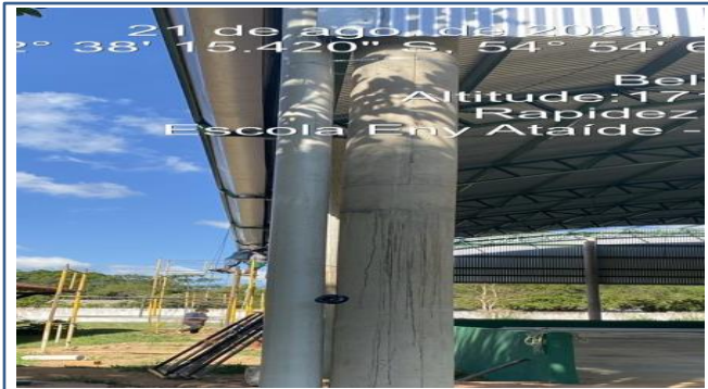
FOTO 07: ITEM 8.1 - Calha em chapa galvanizada
