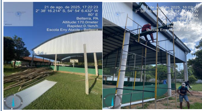
FOTO 05: ITEM 7.2 - Cobertura - telha em aço galvanizado e=0,5mm
