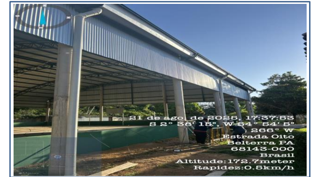
FOTO 09 : ITEM 8.1 - Calha em chapa galvanizada
