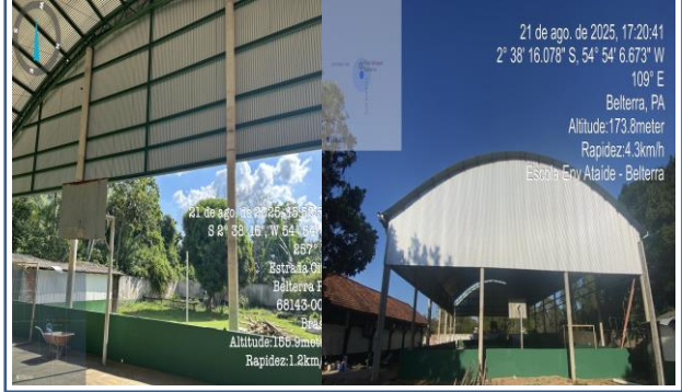
FOTO 06: ITEM 7.2 - Cobertura - telha em aço galvanizado e=0,5mm
