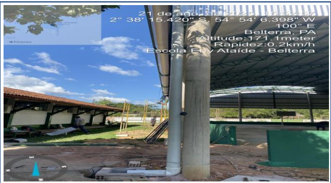
FOTO 14: ITEM 8.7: JOELHO 90 GRAUS, PVC, SERIE R, ÁGUA PLUVIAL, DN 150 MM, JUNTA ELÁSTICA, FORNECIDO E INSTALADO EM CONDUTORES VERTICAIS DE ÁGUAS PLUVIAIS. AF_06/2022
