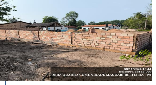
FOTO 18: ITEM 1.4 - Alvenaria tijolo de barro a cutelo 9 x 14 x 19
