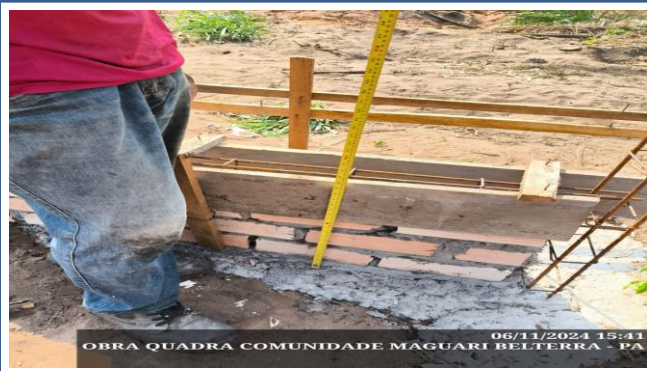
FOTO 01 : ITEM 1.2 - Aterro incluindo carga, descarga, transporte e apiloamento
