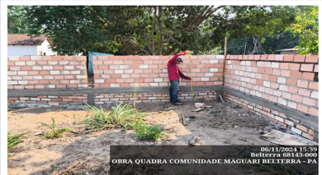
FOTO 16: ITEM 1.4 - Alvenaria tijolo de barro a cutelo 9 x 14 x 19
