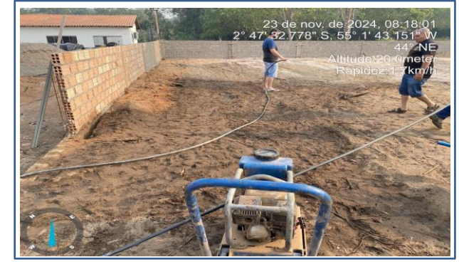
FOTO 09: ITEM 1.2 - Aterro incluindo carga, descarga, transporte e apiloamento.
