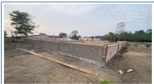
FOTO 19: ITEM 1.5 - CHAPISCO APLICADO EM ALVENARIA (COM PRESENÇA DE VÃOS) E ESTRUTURAS DE CONCRETO DE FACHADA, COM COLHER DE PEDREIRO. ARGAMASSA TRAÇO 1:3 COM PREPARO EM
