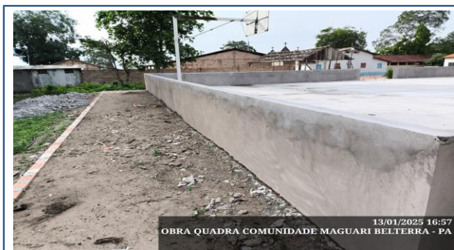
FOTO 22: ITEM 1.6 - Reboco com argamassa 1:6:Adit. Plast
