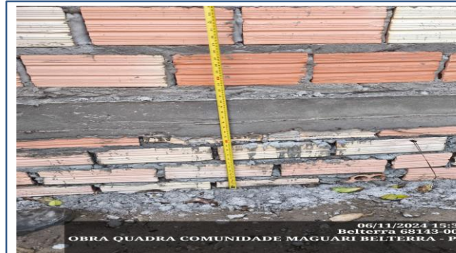
FOTO 05: ITEM 1.2 - Aterro incluindo carga, descarga, transporte e apiloamento
