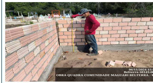
FOTO 17: ITEM 1.4 - Alvenaria tijolo de barro a cutelo 9 x 14 x 19
