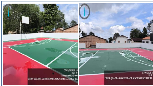
FOTO 23: ITEM 1.7 PINTURA DE PISO COM TINTA ACRÍLICA, APLICAÇÃO MANUAL, 2 DEMÃOS, INCLUSO FUNDO
