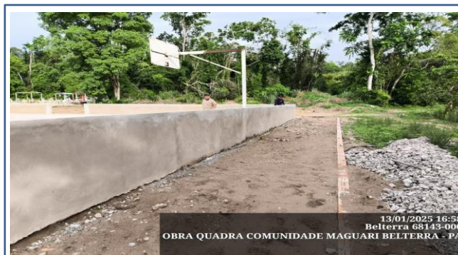
FOTO 14: ITEM 1.3 - EXECUÇÃO DE PASSEIO (CALÇADA) OU PISO DE CONCRETO COM CONCRETO MOLDADO IN LOCO, FEITO EM OBRA, ACABAMENTO CONVENCIONAL, NÃO ARMADO. AF_08/2022
