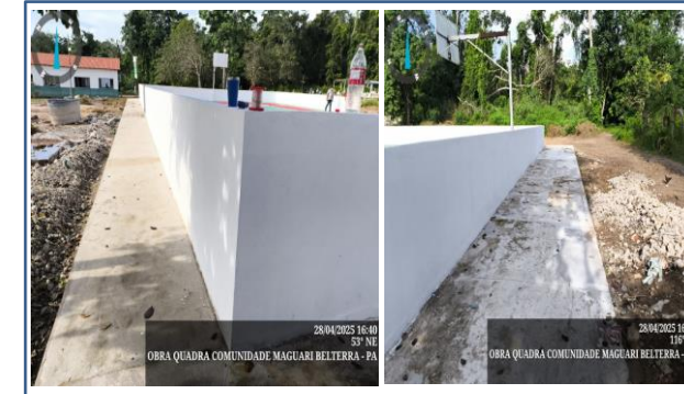
FOTO 24: ITEM 1.9 - Pintura de acabamento com aplicação de 02 demãos de tinta acrílica convencional
