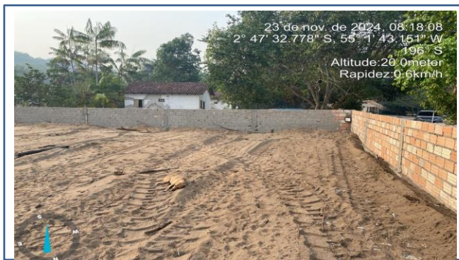
FOTO 07 : ITEM 1.2 - Aterro incluindo carga, descarga, transporte e apiloamento
