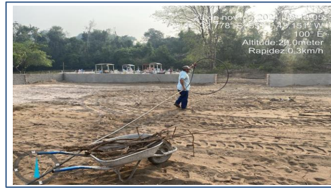
FOTO 08 : ITEM 1.2 - Aterro incluindo carga, descarga, transporte e apiloamento
