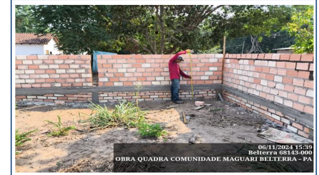
FOTO 06: ITEM 1.2 - Aterro incluindo carga, descarga, transporte e apiloamento
