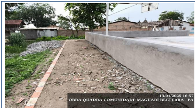
FOTO 13: : ITEM 1.3 - EXECUÇÃO DE PASSEIO (CALÇADA) OU PISO DE CONCRETO COM CONCRETO MOLDADO IN LOCO, FEITO EM OBRA, ACABAMENTO CONVENCIONAL, NÃO ARMADO. AF_08/2022
