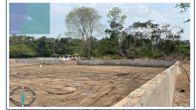
FOTO 12 : ITEM 1.2 - Aterro incluindo carga, descarga, transporte e apiloamento
