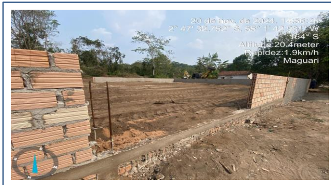
FOTO 10 : ITEM 1.2 - Aterro incluindo carga, descarga, transporte e apiloamento
