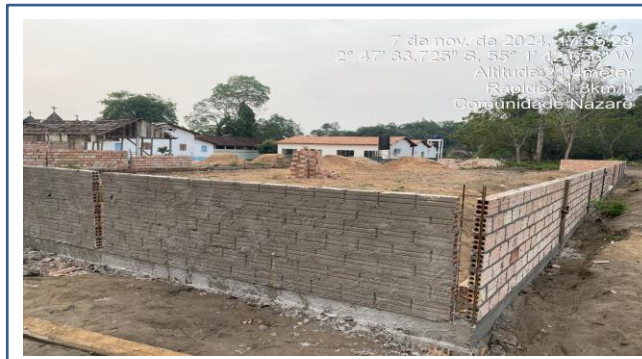
FOTO 20: ITEM 1.5 - CHAPISCO APLICADO EM ALVENARIA (COM PRESENÇA DE VÃOS) E ESTRUTURAS DE CONCRETO DE FACHADA, COM COLHER DE PEDREIRO. ARGAMASSA TRAÇO 1:3 COM PREPARO EM BETONEIRA 400L. AF_10/2022
