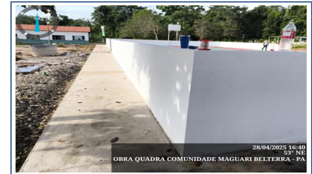
FOTO 15: ITEM 1.3 - EXECUÇÃO DE PASSEIO (CALÇADA) OU PISO DE CONCRETO COM CONCRETO MOLDADO IN LOCO, FEITO EM OBRA, ACABAMENTO CONVENCIONAL, NÃO ARMADO. AF_08/2022
