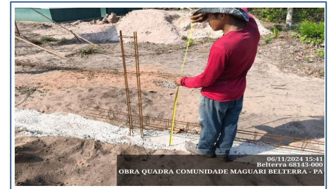
FOTO 03: ITEM 1.2 - Aterro incluindo carga, descarga, transporte e apiloamento
