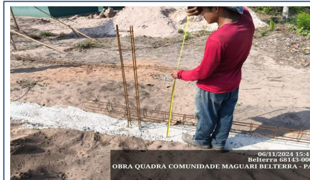
FOTO 02: ITEM 1.2 - Aterro incluindo carga, descarga, transporte e apiloamento
