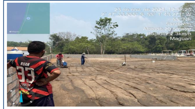
FOTO 11 : ITEM 1.2 - Aterro incluindo carga, descarga, transporte e apiloamento
