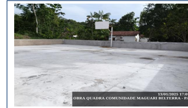
FOTO 21: ITEM 1.6 Reboco com argamassa 1:6:Adit. Plast.
