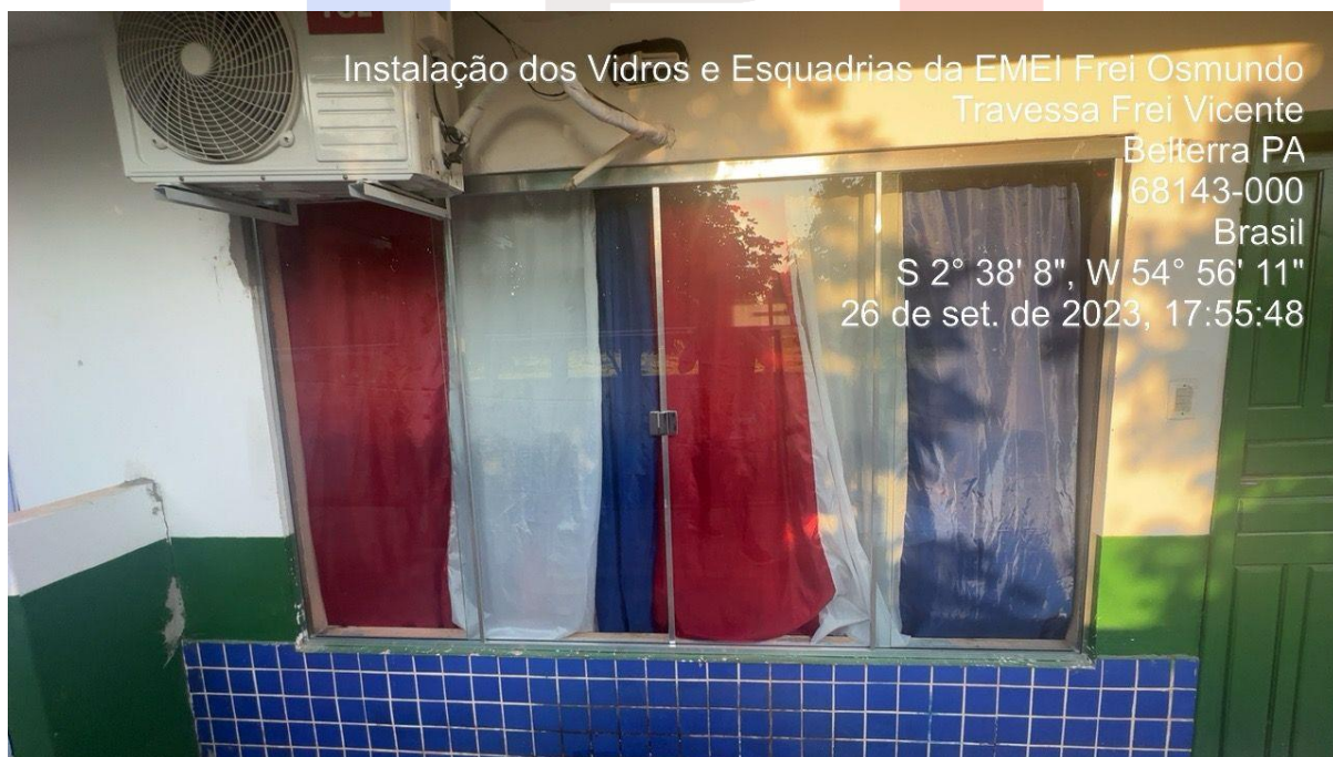
IMAGEM 06 – Instalação dos vidros da EMEI Frei Osmundo
