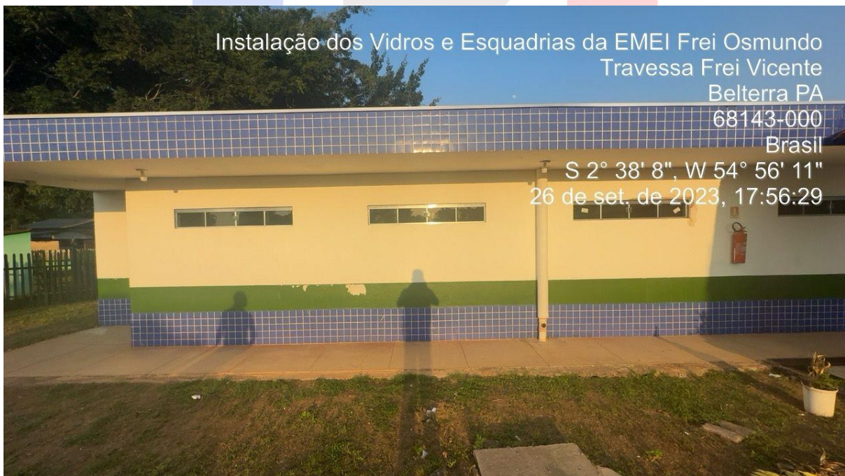
IMAGEM 08 – Instalação dos vidros da EMEI Frei Osmundo
