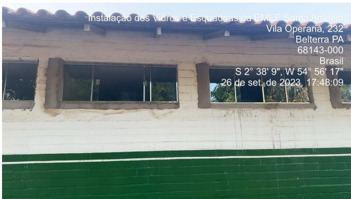
IMAGEM 07 – Instalação dos vidros da EMEF Santo Antônio
