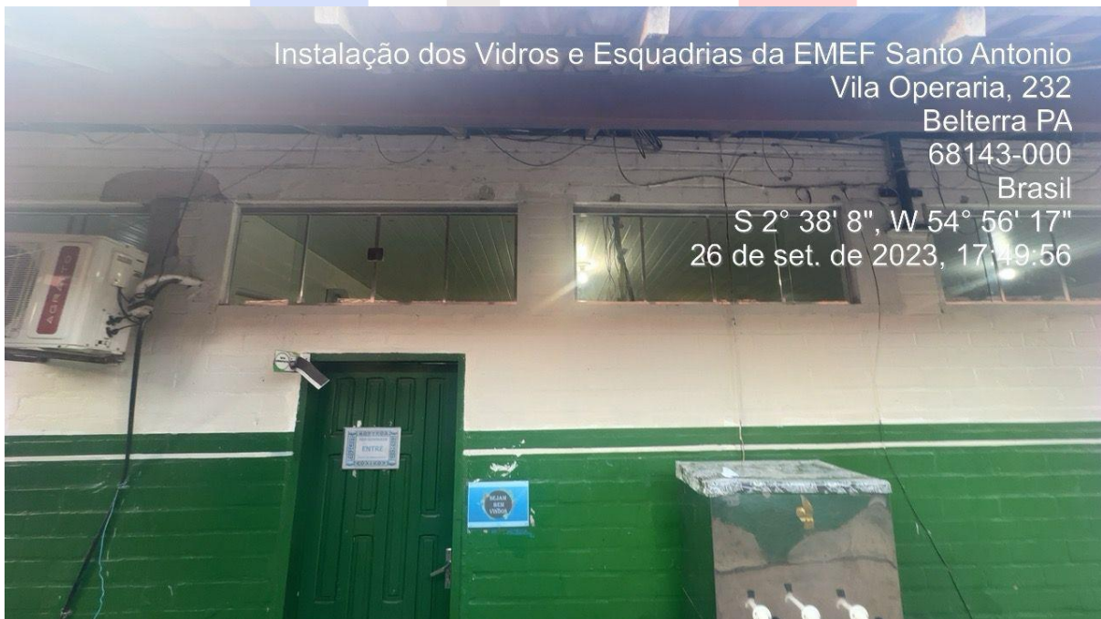
IMAGEM – 10 Instalação dos vidros da EMEF Santo Antônio
