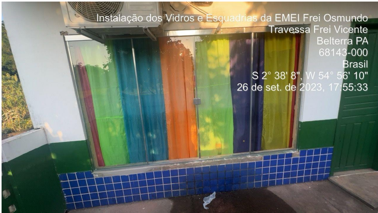
IMAGEM 07 – Instalação dos vidros da EMEI Frei Osmundo
