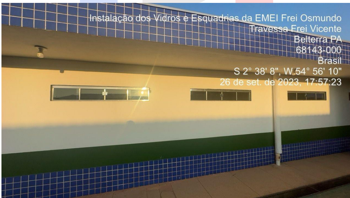
IMAGEM 10 – Instalação dos vidros da EMEI Frei Osmundo
