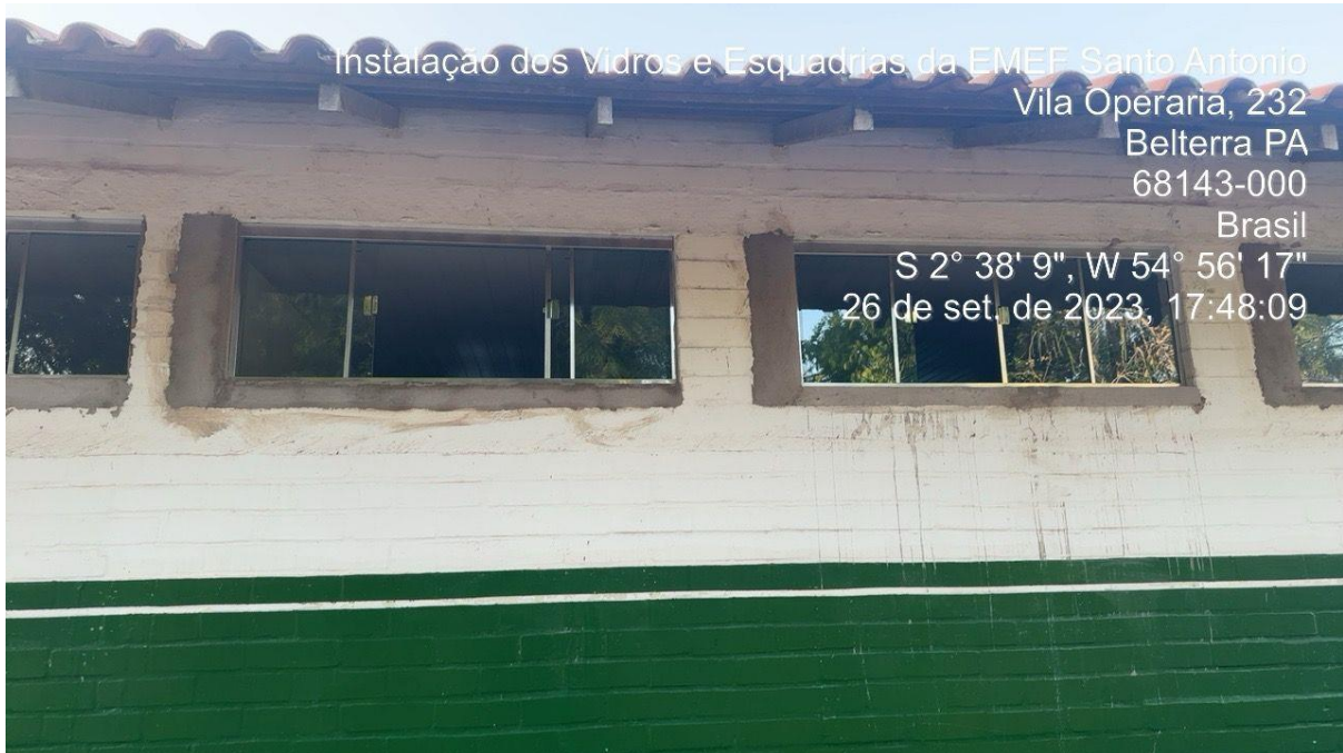
IMAGEM – 09 Instalação dos vidros da EMEF Santo Antônio
