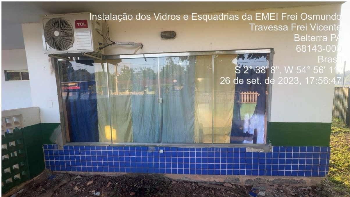
IMAGEM 09 – Instalação dos vidros da EMEI Frei Osmundo
